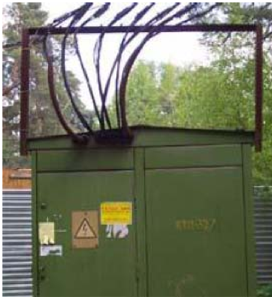
Рис. 1.35. Закрепление вводов на подстанцию
