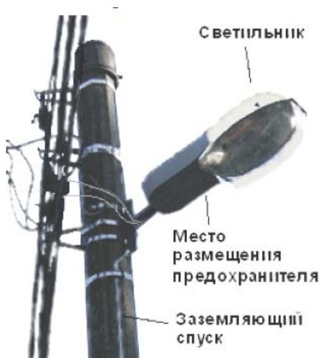
Рис. 1.30. Монтаж уличного светильника
