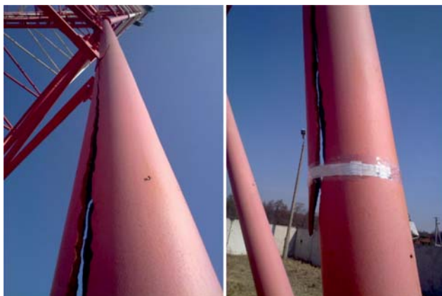
Рис. 6. Разрушение трубчатого профиля металлоконструкции АМС
