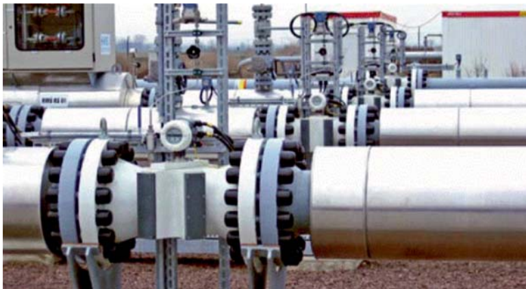
Рис. 1. Ультразвуковой расходомер Flowsic-600 на месте установки
