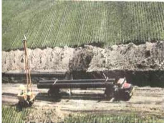
*Рис. 5.3.2. Перевозка секций труб*
