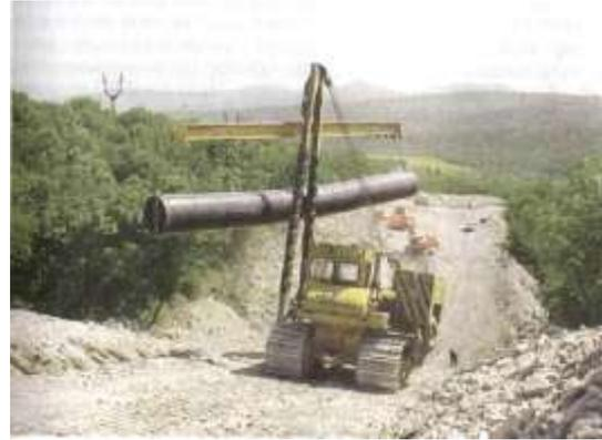
*Рис. 5.3.3. Транспортировка труб трубоукладчиком*
