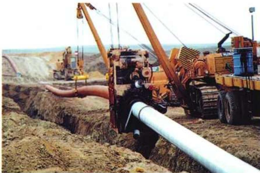
*Рис. 5.5.5. Укладка плети трубопровода в траншею*
