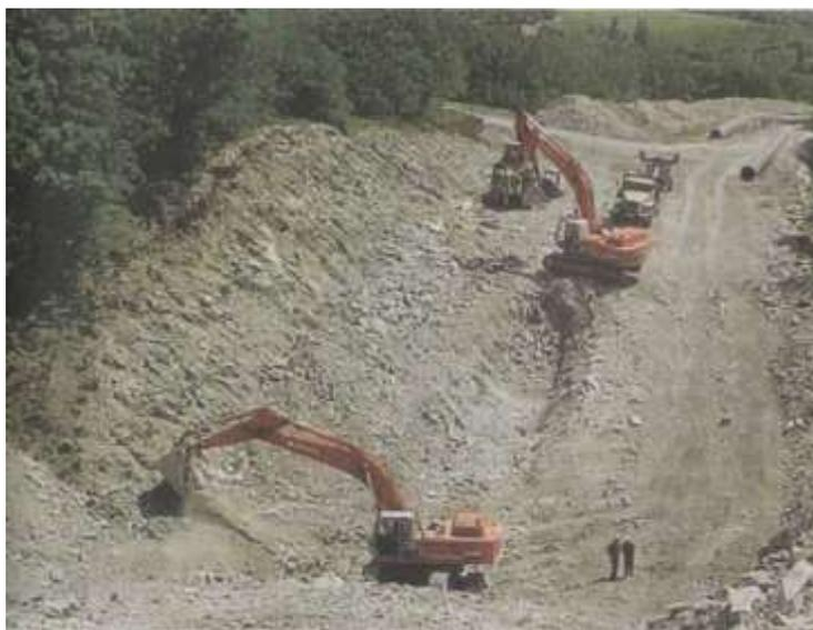
*Рис. 5.4.1. Разработка траншеи одноковшовым экскаватором в горах [36]*
