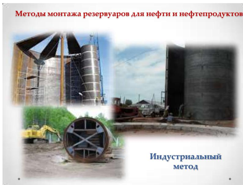
*Рис. 5.10.10. Рулонный метод монтажа резервуара*
