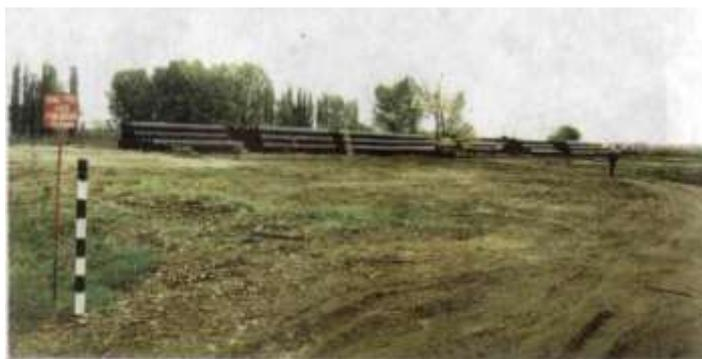
*Рис. 5.3.1. Складирование труб на подготовительной площадке*
