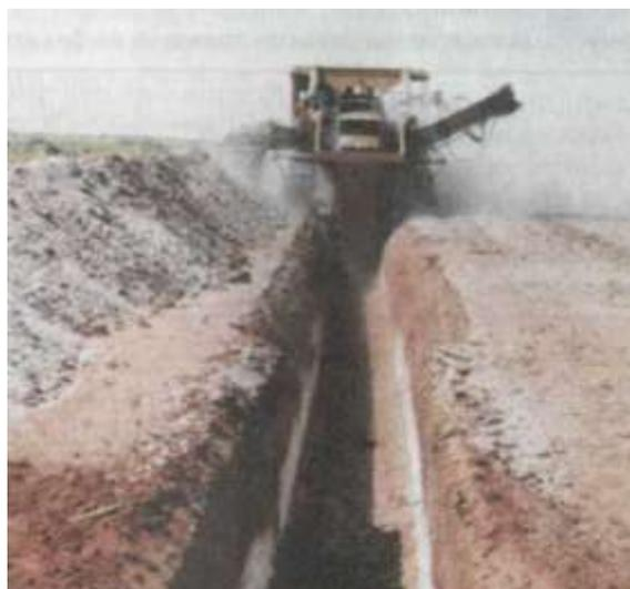
*Рис. 5.4.2. Разработка траншеи роторным экскаватором [36]*
