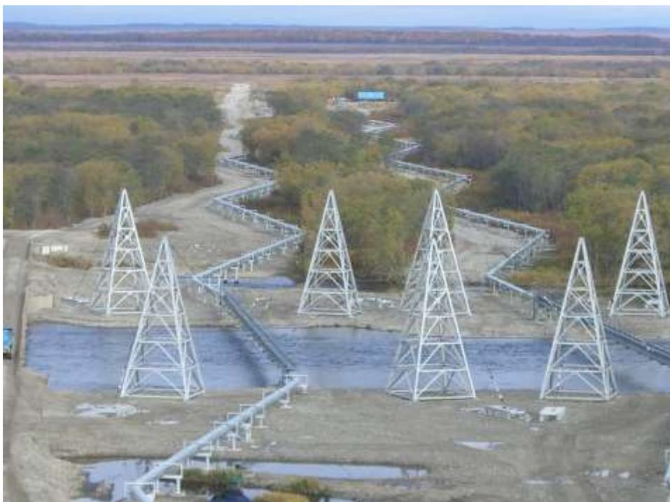
*Рис. 5.10.8. Надземный трубопровод*
