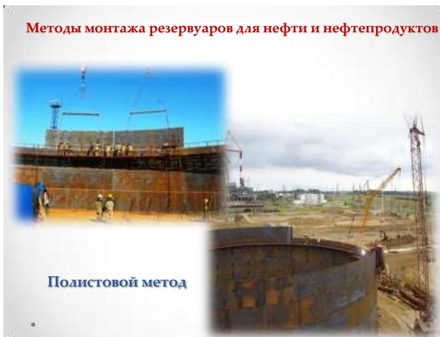
*Рис. 5.10.12. Монтаж резервуара*
