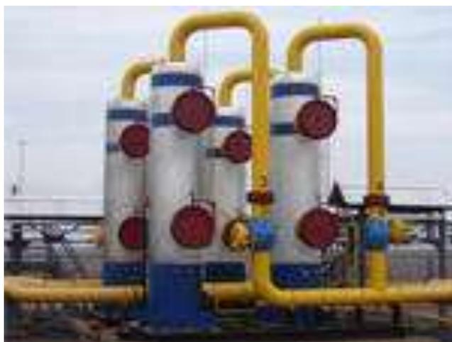
Рис. 41. Общий вид циклонного пылеуловителя
