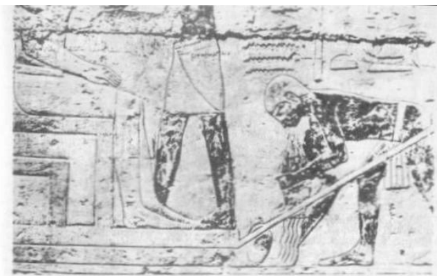
Рис.1. Применение масла для уменьшения силы трения при перемещении статуи
